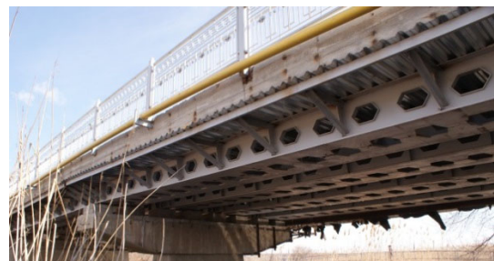
Рис.5. Загальний вигляд прогонової будови (вид знизу).
