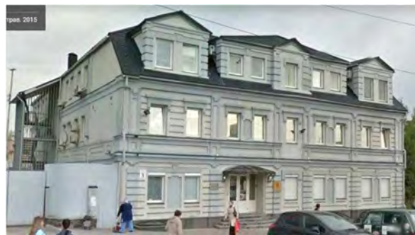
Рис.1. Будівля до реконструкції, головний фасад
