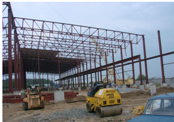
Рис.1. Загальний вигляд металевого каркасу будівлі.
