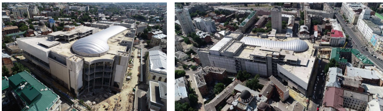
Рис.2. Загальні види будівельного об'єкту (2020 р.).
