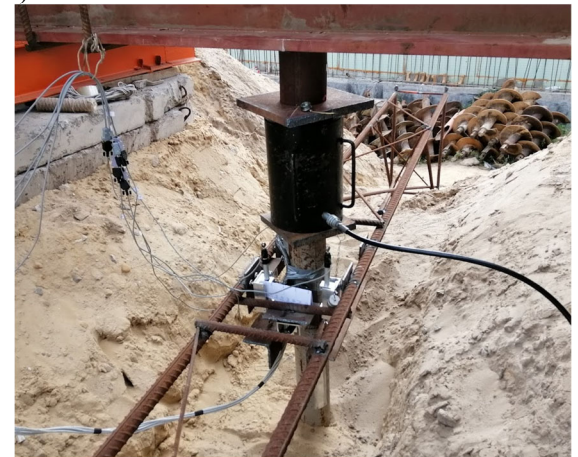
Рис.1. Експериментальний майданчик для випробування групи палей «Pile test-2019»: а) загальний вид майданчика; б) встановлення тензодатчиків та датчиків переміщення на дослідні палі.
