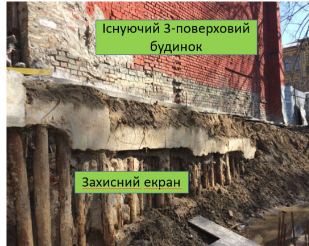
Рис.2. Влаштований захисний екран із труб Fig.2. Protective screen made of pipes
