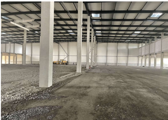
Рис.6. Приклад влаштованої основи під промислову підлогу.
