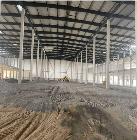
Рис.5. Влаштування піщаної основи товщиною від 1,5 – 4,7м: а – влаштування основи та її ущільнення котками з зубчастими вальцями; б – влаштування основи та її ущільнення котками з гладкими вальцями; с - втрамбування шару щебня в насипну частину; d - укладання та ущільнення щебенево – піщаної суміші, основного шару під промислову підлогу.
