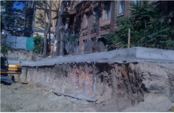
Рис. 3. Перший етап екскавації котловану з попередньо влаштованими палями захисного екрану.
