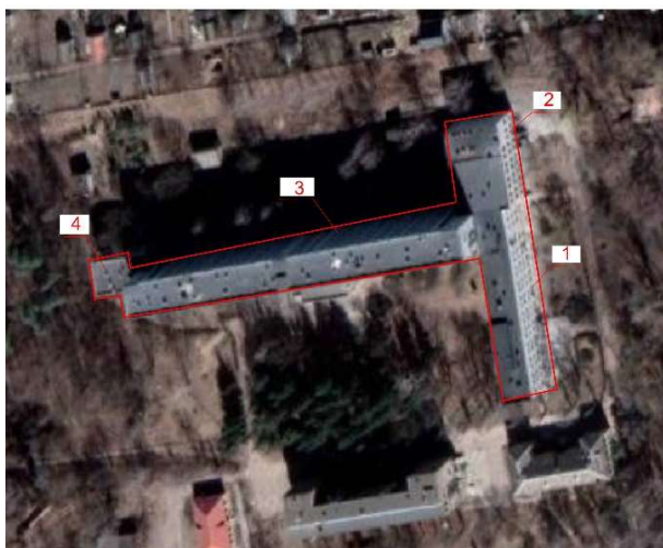
Рис.1. Корпус лікарні: 1 – дитяче відділення; 2 – харчоблок; 3 – основний блок, лікарня; 4 – прибудова, операційний блок.
