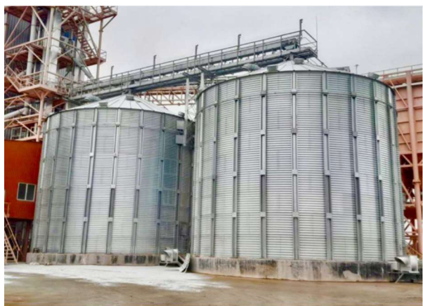
Рис.4. Загальний вид силосів у смт. Дружба Тернопільської обл.
