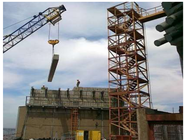
Рис.4. Монтаж елементів навантаження.
