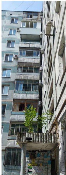
Рис. 8. Загальний вигляд деформаційного шва між блок-секціями №3 та №1: до вирівнювання; після вирівнювання в м. Запоріжжі по вул. Інженера Преображенського 23, 25.
