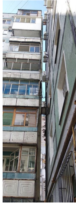
Рис. 8. Загальний вигляд деформаційного шва між блок-секціями №3 та №1: до вирівнювання; після вирівнювання в м. Запоріжжі по вул. Інженера Преображенського 23, 25.
