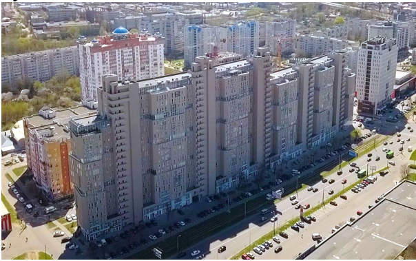
Рис.19. Загальний вигляд будівлі на завершальному етапі будівництва
