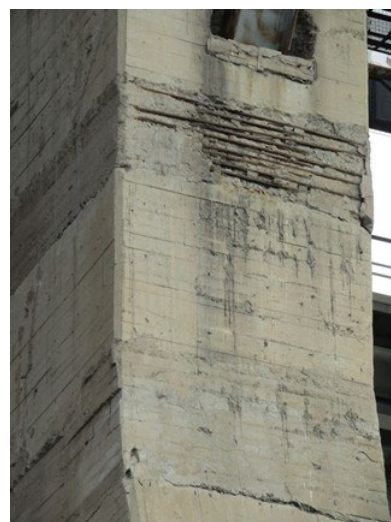
Рис. 10. Загальний вид водозливної поверхні між опорами № 3 і № 4. Руйнування бетону, оголення та корозія арматури, сколи бетону опор №№ 18, 21 Fig. 10. General view of the spillway surface between supports No. 3 and No. 4. Destruction of concrete, exposure and corrosion of reinforcement, concrete chips of supports No. 18, 21
