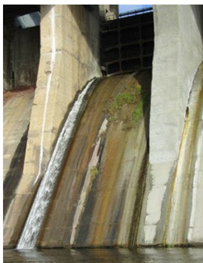
Рис. 10. Загальний вид водозливної поверхні між опорами № 3 і № 4. Руйнування бетону, оголення та корозія арматури, сколи бетону опор №№ 18, 21 Fig. 10. General view of the spillway surface between supports No. 3 and No. 4. Destruction of concrete, exposure and corrosion of reinforcement, concrete chips of supports No. 18, 21
