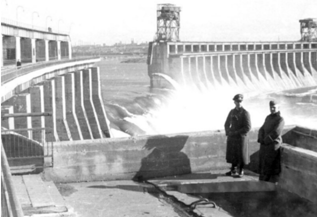
Рис. 3. Види на водозливну греблю Дніпровської ГЕС після вибухів у 1941 р. та бики № 22-25, підірвані з вертикальних вентиляційних шахт (з боку нижнього б'єфу) (memorua.org, 1941)
