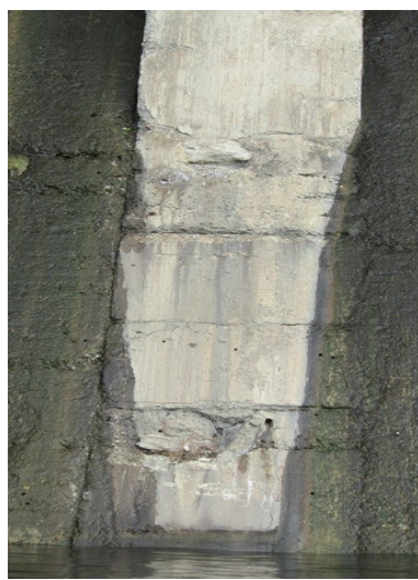
Рис. 10. Загальний вид водозливної поверхні між опорами № 3 і № 4. Руйнування бетону, оголення та корозія арматури, сколи бетону опор №№ 18, 21 Fig. 10. General view of the spillway surface between supports No. 3 and No. 4. Destruction of concrete, exposure and corrosion of reinforcement, concrete chips of supports No. 18, 21
