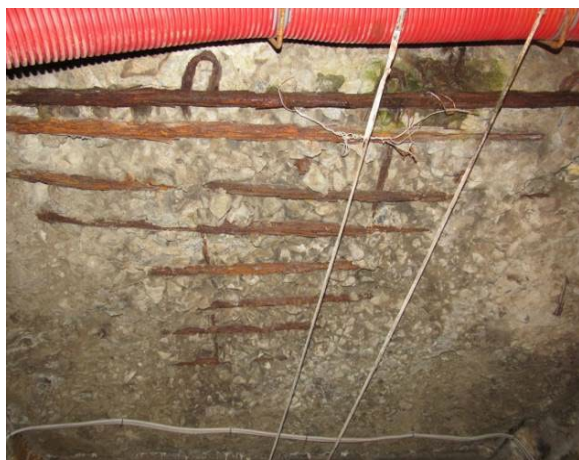
Рис. 9. Руйнування бетону потерни, оголення та пластинчаста корозія арматури, сліди замочання Fig. 9. Destruction of concrete, abrasion, exposure and lamellar corrosion of reinforcement, traces of soaking
