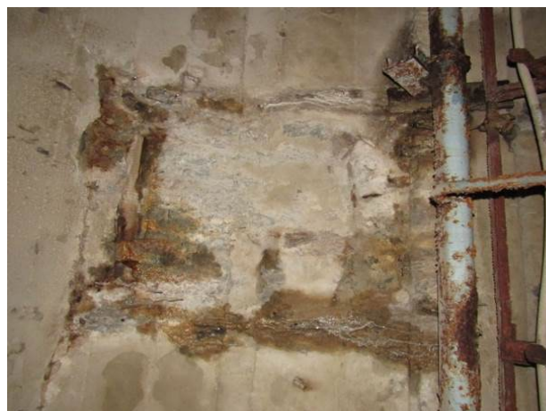
Рис. 9. Руйнування бетону потерни, оголення та пластинчаста корозія арматури, сліди замочання Fig. 9. Destruction of concrete, abrasion, exposure and lamellar corrosion of reinforcement, traces of soaking
