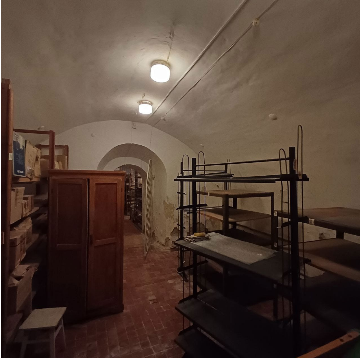
Рис.2. Загальний вигляд підвального приміщення. Fig.2. General view of the basement premises.
