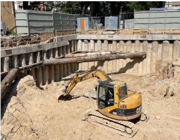
Рис.2. Ділянка будівництва та підпірні стіни. Fig.2. Construction site and retaining walls.
