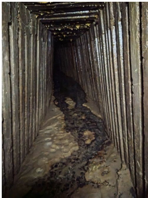
Рис.5. Замуленість та соляні відкладення в штольні №40 Fig.5. Siltage and salt deposits in adit No. 40
