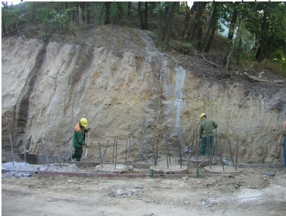
Рис.6 – Оголовки бурунабивних паль по периметру Андріївського пагорбу.
